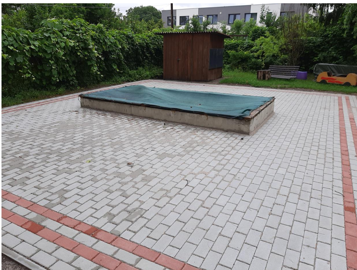
Rekonstrukce chodníků kolem pískovišť – Mateřská škola Sluníčko.
